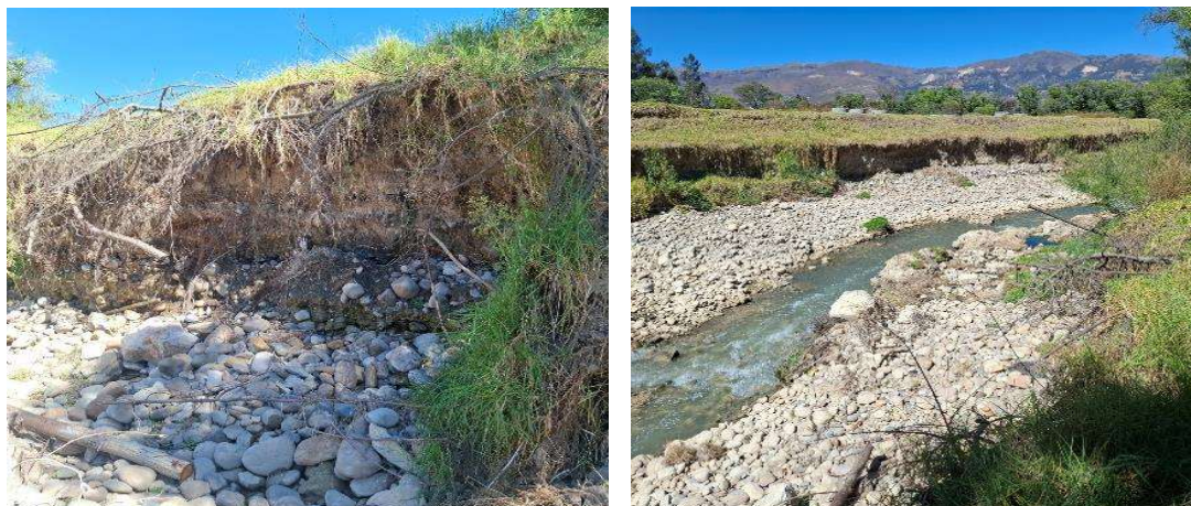
FIGURA N°03: TRAMO CRÍTICO EN EL RÍO CHONTA, SE APRECIA LAS RIBERAS DEL RIO QUE ESTAN SIENDO SOCAVADAS
