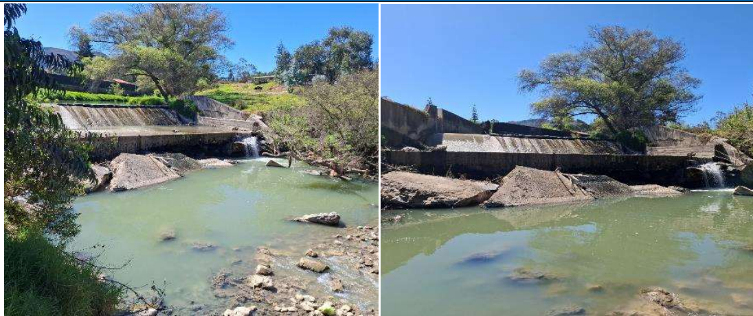
FIGURA N°01: TRAMO CRÍTICO EN EL RÍO CHONTA, SE APRECIA EL SOCAVAMIENTO DE BOCATOMA DEL CANAL DE RIEGO CRISTO REY
